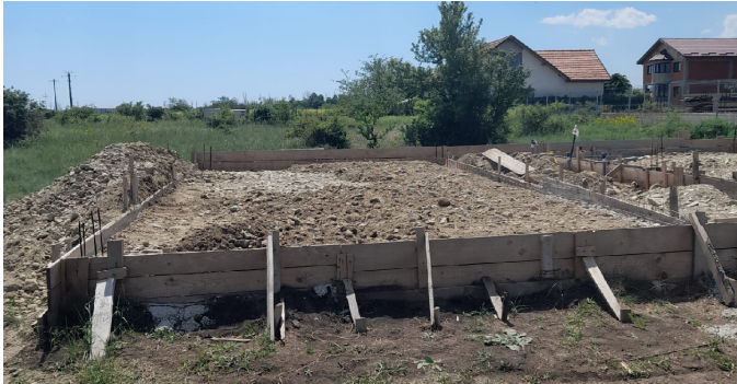
De fundamenteën in aanbouw in 2024
