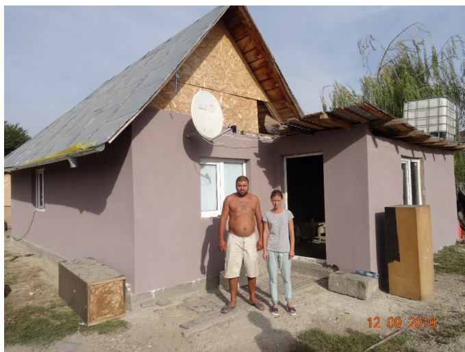
project van 2018: huis uitgebreid, voorzien van betere fundering, dakgoot en polystyreenisolatie
