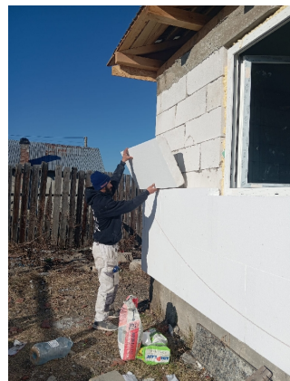
muurisolatie met polystyreen, binnendeuren, laminaat
