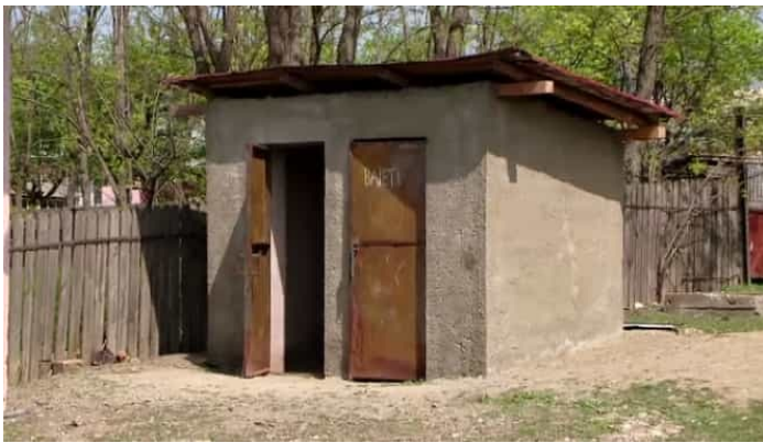
buitentoilet bij plattelandsschooltje (zonder stromend water)
