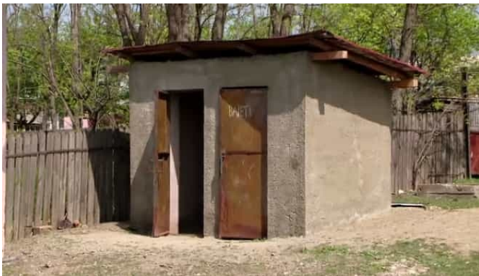
buitentoilet bij plattelandsschooltje (zonder stromend water)
